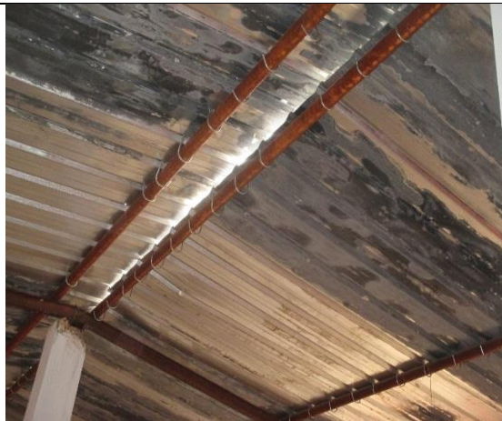
Photo 14 : Toit mal posé dans la ferme villageoise Malem Hodar
