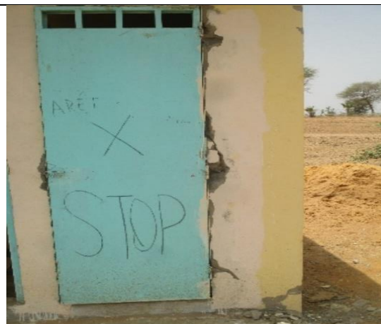
Photo 16 : Toilettes de la ferme de Ndoffane mouride qui ne ferme avec un bâtiment fissuré
