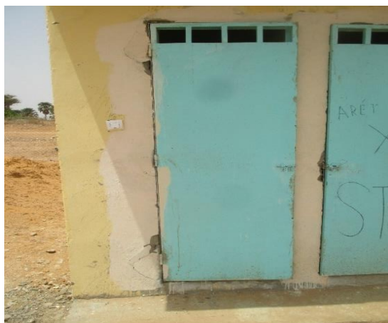
Photo 15 : Toilettes de la ferme de Ndoffane mouride qui ne ferme avec un bâtiment fissuré
