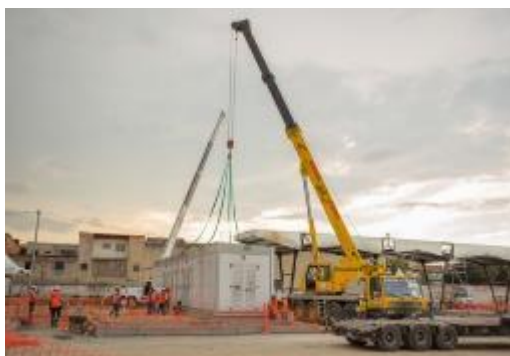
(a) Instalação de uma mini subestação no depósito de 47 autocarros (b) Actualização do depósito 48 de autocarros (c) 49
